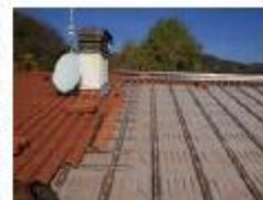
LA POSA IN OPERA DEI PANNELLI PANTHER DI ISOLCONFORT
