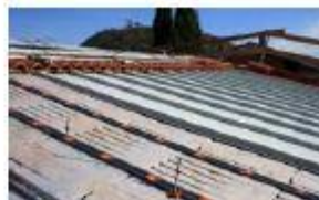
LE BARRE FILETTATE PER L'AGGANCIO IN COPERTURA DEGLI ELEMENTI FOTOVOLTAICI
